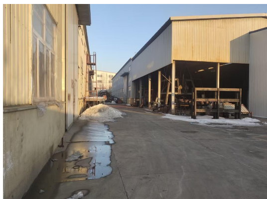
厂房南侧为 2#厂房
