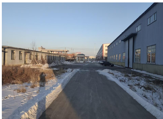
厂房北侧办公室、综合楼
