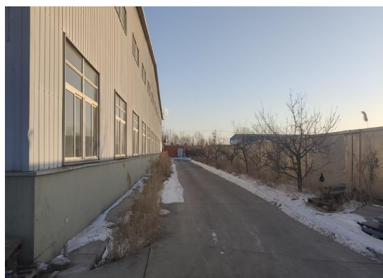
厂房西侧现状（3、4#厂房相通，院内空地）
